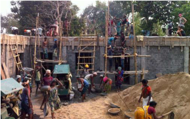
Betonage der Decke des Gemeindehauses
