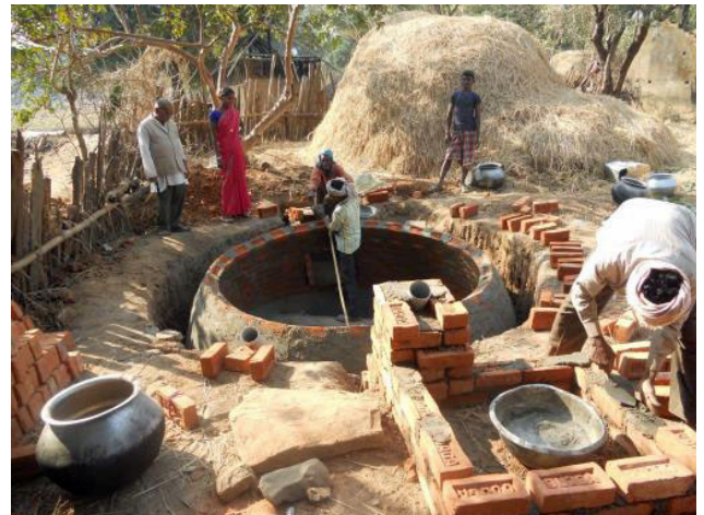
Mauern der Kuppel einer Bio-gasanlage
