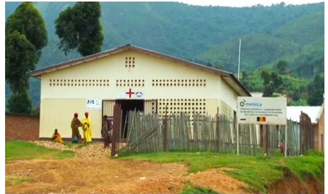
Eine von MEMISA in der DR Congo errichtet Geburtsstation
